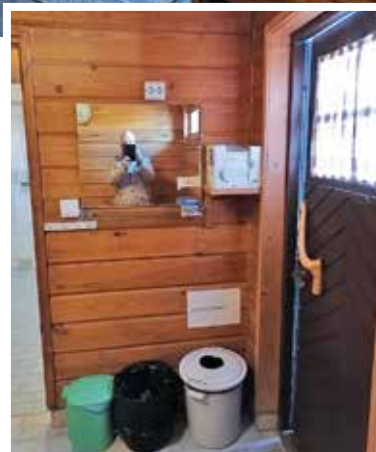
▲ Pukuhuoneen oviseinä ennen remonttia.
