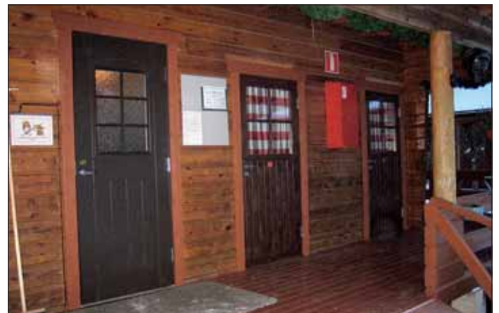
Pirtin uudet ovet pitävät lämmön hyvin sisällä.
