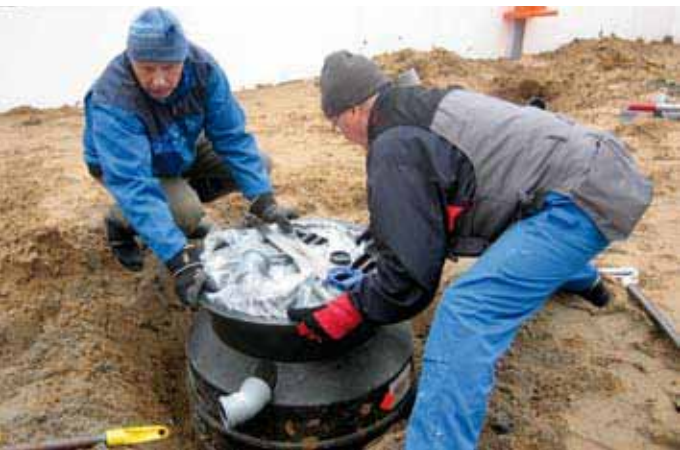
Monenlaisia työvaiheita mahtui Rantasaran uuden Konehallin rakentamiseen.
