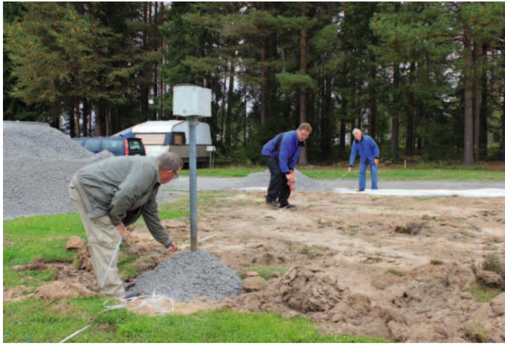
Uusien turvavälien mukaisten vaunupaikkojen mittaustyöt käynnissä.
