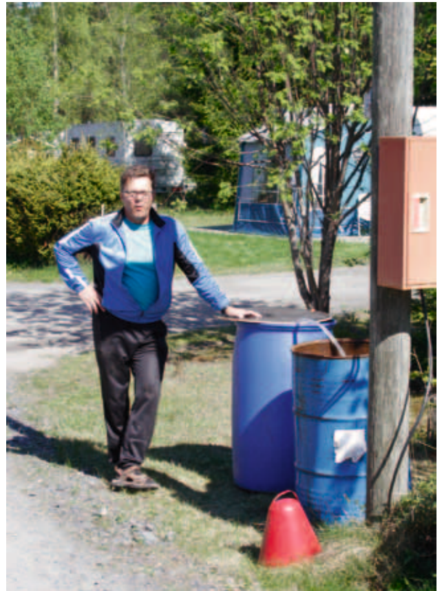
Turvallisuuspäällikkö asentamassa uusia muovisia palovesitynnyreitä paikoilleen alueella.
