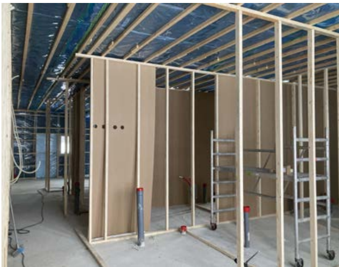
Lattiat valettu ja väliseinin pystytys alkoi helmikuussa 2021.
